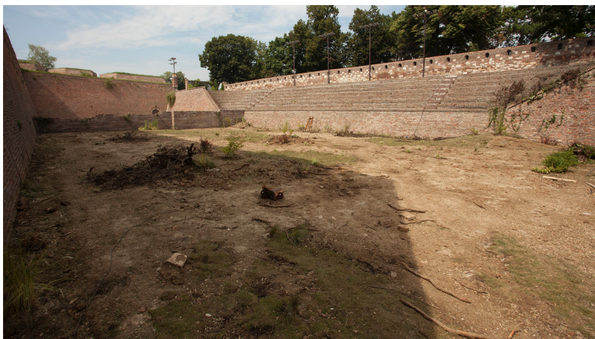
Fotografije izgradnje objekta
