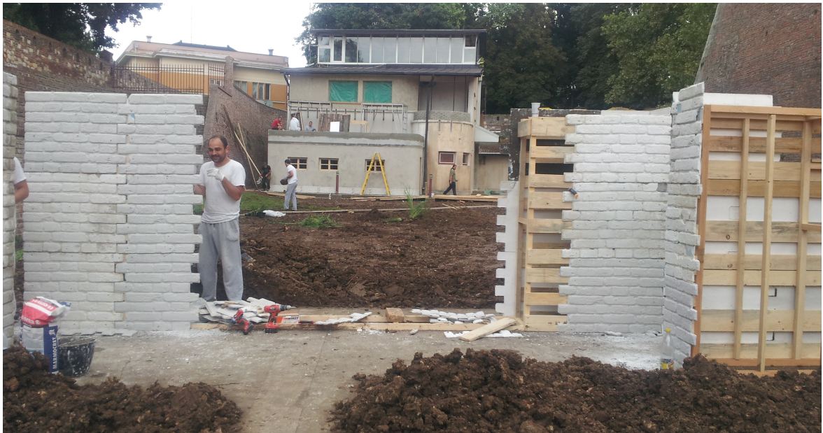
Fotografije izgradnje objekta
